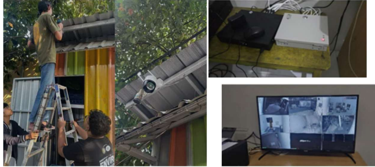
Gambar 3 Dokumentasi pemasangan smart CCTV
